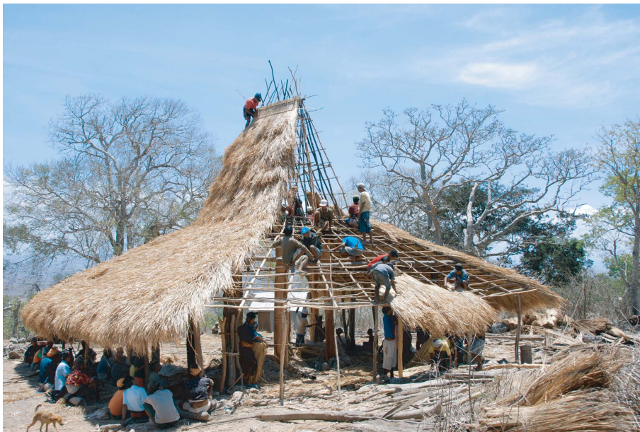
写真2 「大きな家」の屋根葺き
