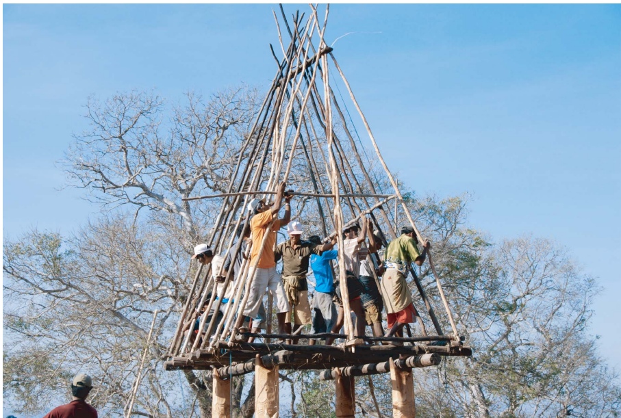
写真1 「大きな家」の屋根頂部の組み立て
