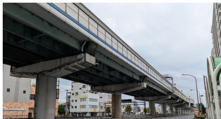
高速道路を支える橋脚
