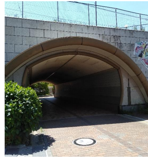
④プラザを抜け、左に曲がると、トンネルがあります。
