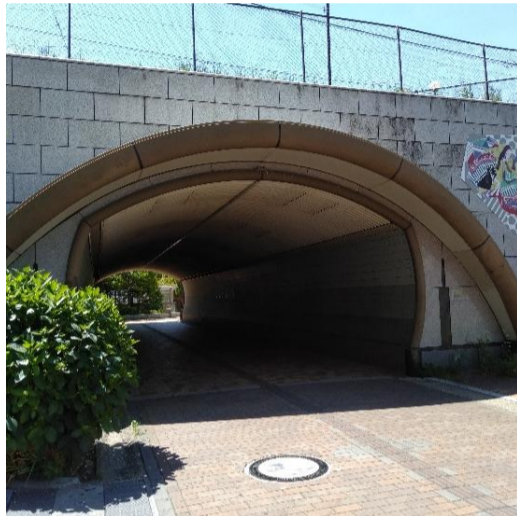
④プラザを抜け、左に曲がると、トンネルがあります。
