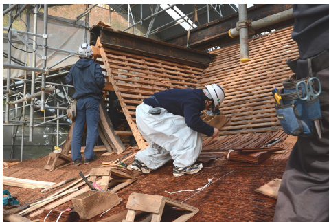
本社本殿檜皮屋根葺替のようす
