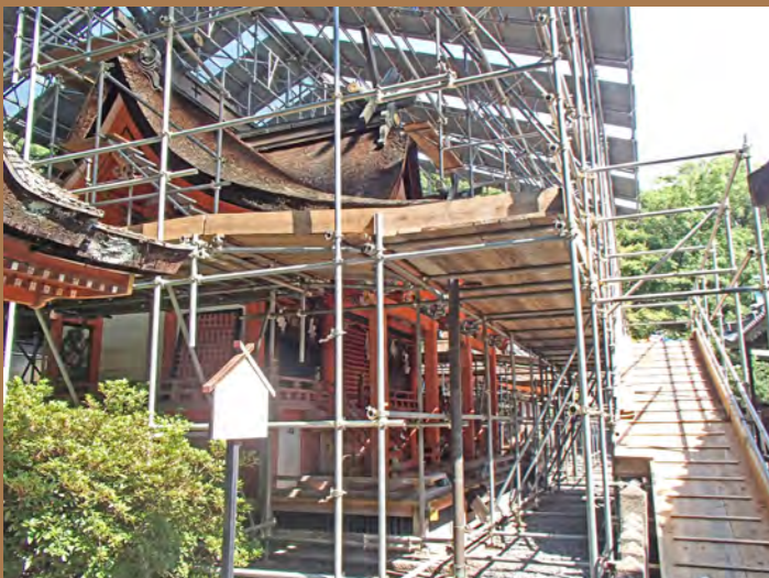
工事用の足場
