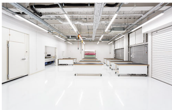
写真 3 LAYUP ROOM【工程】①②③
