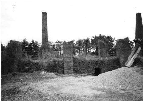
写真Ⅱ－３ 楕円形ホフマン窯の長手方向から見た外観（撮影：並川）
