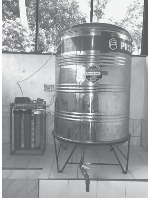
Figure 9 児童養護施設で使用されている浄水装置
