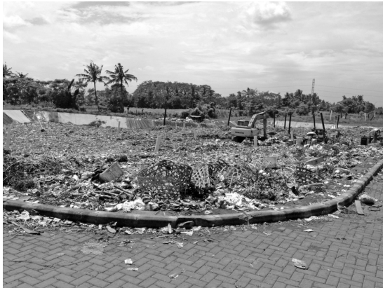
Figure 16 テメシ・コンポストの廃棄物投棄場
