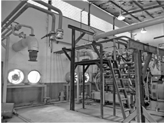
Figure 12 ランドフィルガスでの発電機 17)
